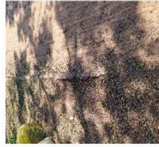
Veredas y pavimentos Fuente: Fotos tomadas en agosto 2017
